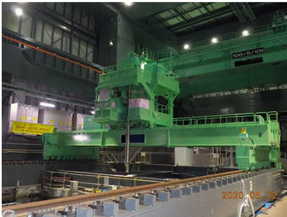
燃料取扱機取り外し前 (撮影：2020年5月22日)
