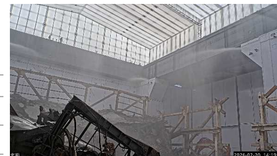
カバー内噴霧状況
