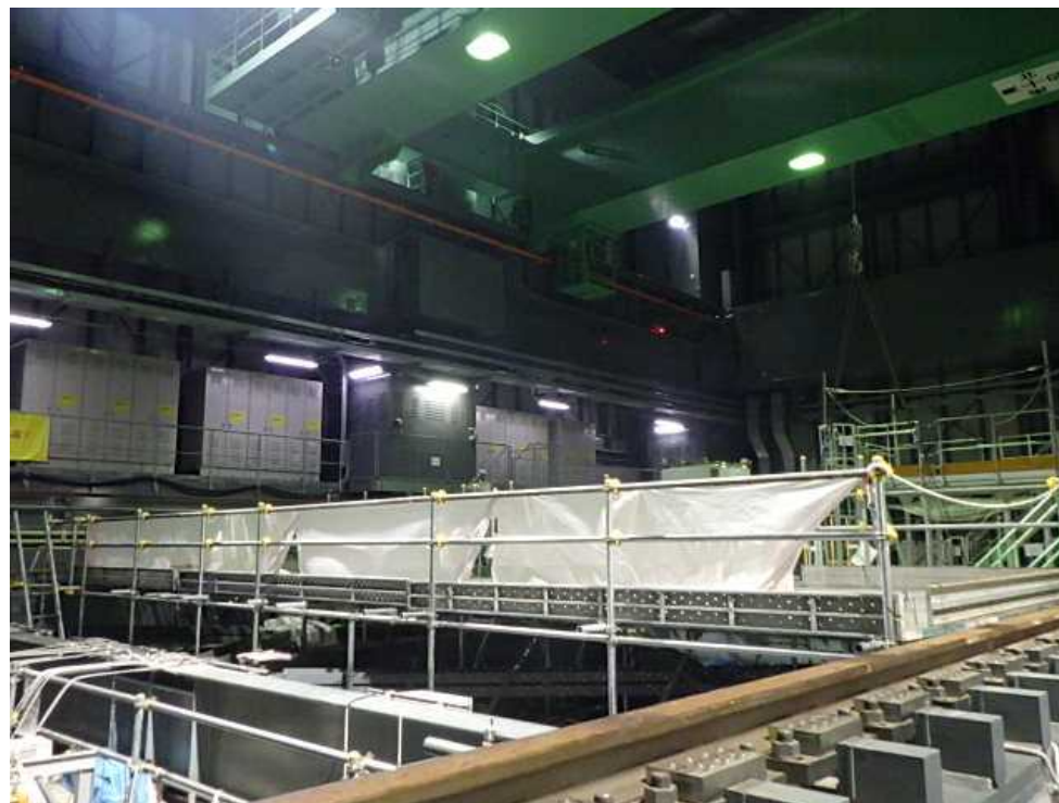
燃料取扱機取り外し後 (撮影：2026年2月18日)
