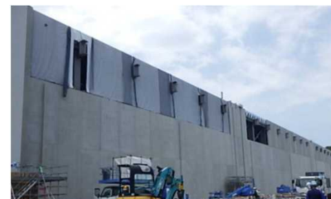
補強工事中の状況
