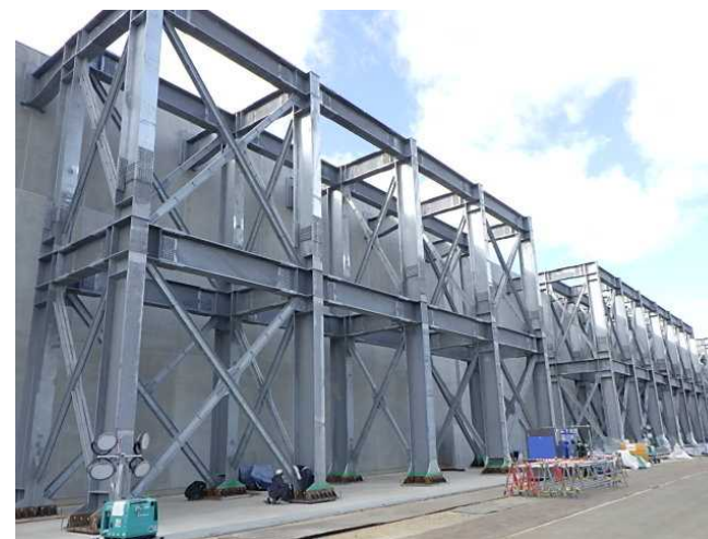
補強工事完了後の状況
