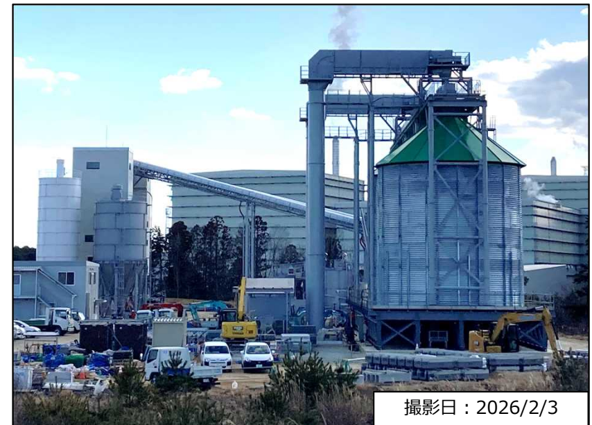
コンクリートプラント全景
