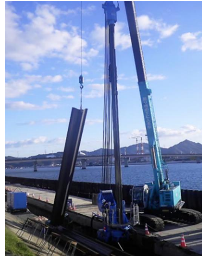
写真1 施工イメージ
