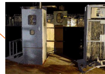
北側シェル壁点群
