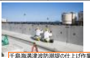
千島海溝津波防潮堤の仕上げ作業
