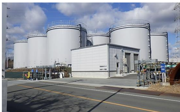
【移送ポンプ建屋設置状況】撮影方向② (2026.2.3)
