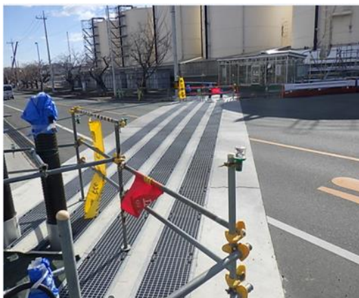
【移送配管（横断部）】撮影方向① (2026.2.3)
