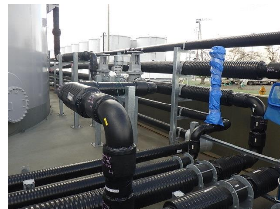
【移送配管敷設状況】(2026.2.3) (集水タンク壇内)
