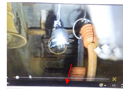
ホースが下方向へ沈んだ状態
