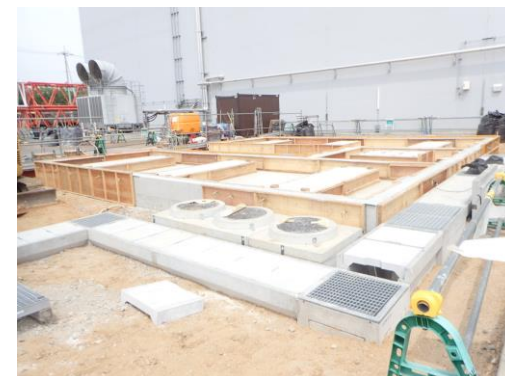
基礎設置作業の状況(2025年4月)
