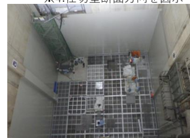
④ピット底板復旧中
