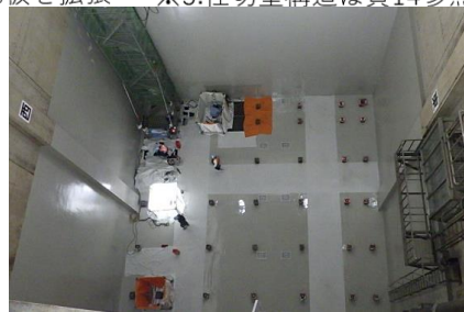
③ピットコンクリート補修後
