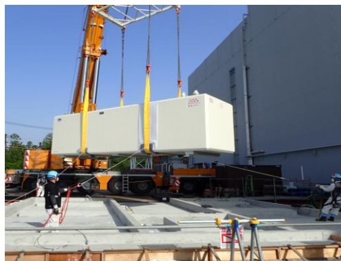
タンク設置作業の状況(2025年5月)
