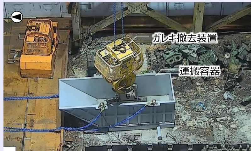
<1号機ガレキ撤去の状況（撮影日：2026年6月22日）>
