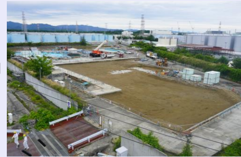
<D1タンク解体後のEエリアの様子（撮影日：2026年6月15日）>
