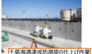
千島海溝津波防潮堤の仕上げ作業
