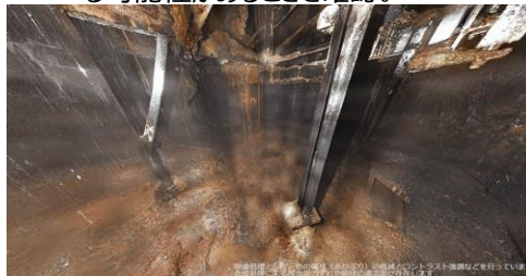
ペDESTAL底部の状況 (パノラマ合成処理後)
