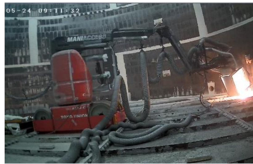
Eエリアタンク内におけるレーザー除染の様子 (2022年5月24日) 3
