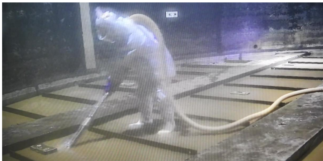
EエリアD1タンク内を洗浄する様子 (2025年12月24日)
