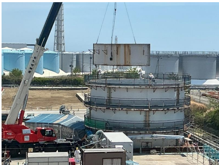
EエリアD1タンク解体作業の様子（2026年5月12日）
