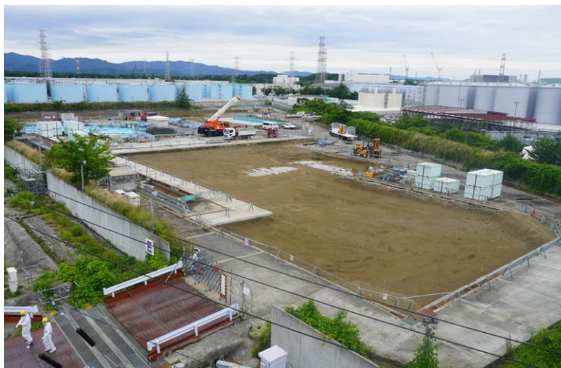
D1タンク解体後のEエリアの様子（2026年6月15日）
