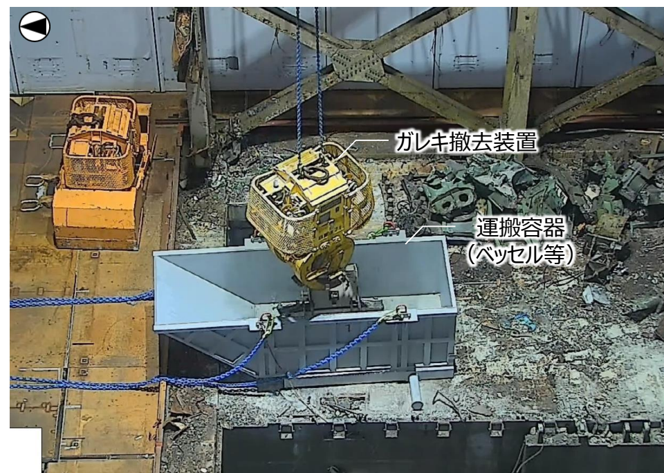
ガレキ撤去の状況 (撮影：2026年6月22日)
