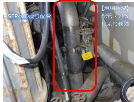
Rw/B1階 貫通部近傍現場状況
