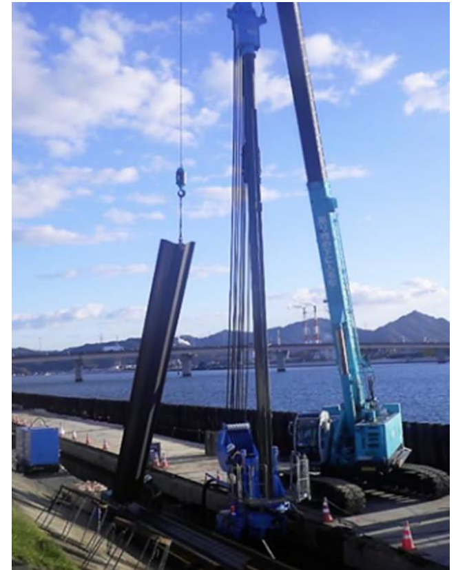
写真1 施工イメージ
