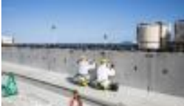
千島海溝津波防潮堤の仕上げ作業
