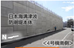
日本海溝津波防潮堤
