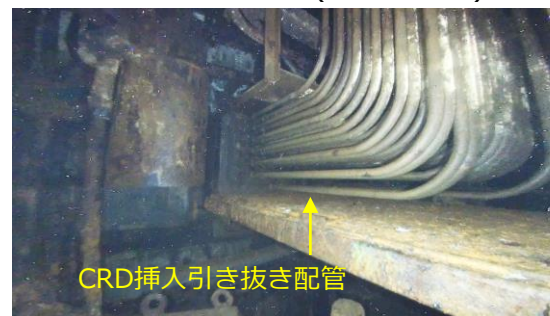
②：CRD挿入引き抜き配管(北東)
