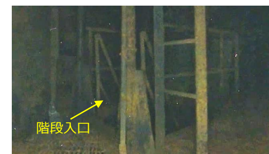
④：地下階段(南)
