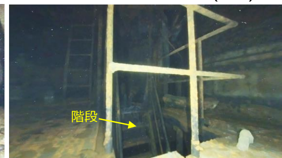
④：地下階段(北)
