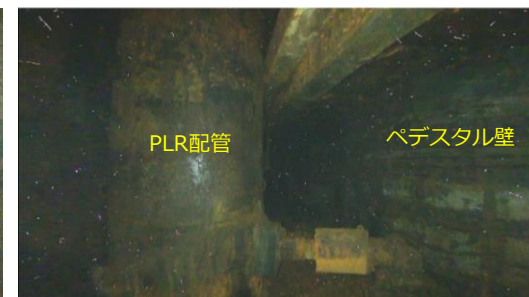
④：ペDESTAL外 東エリア
