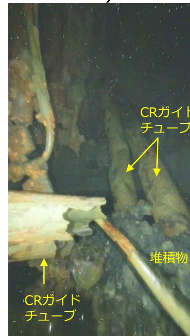
②：落下している構造物
