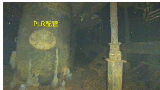
①：ペDESTAL外 北西エリア
