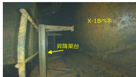
②：ペDESTAL外 南西エリア
