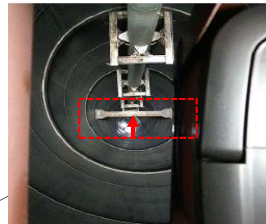
筒身内部鉄骨材（上から視点）
