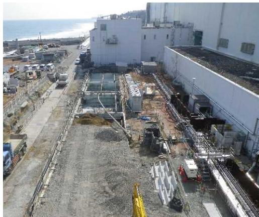
クレーンヤード整備状況【整備中】 〔北側から撮影〕
