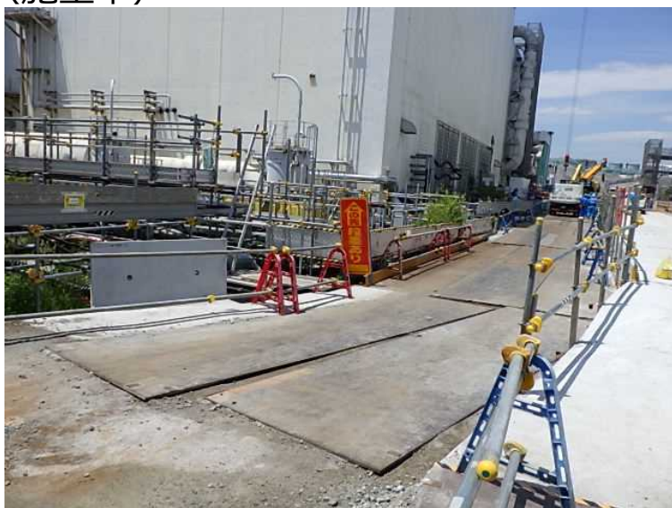
■ 2-3号間道路（海側） 状況写真 （施工中）
