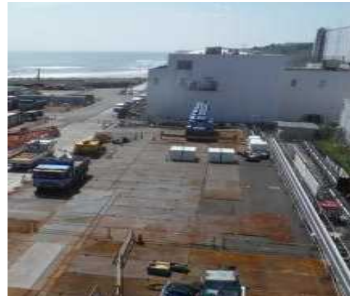
クレーンヤード整備状況【完了】 〔北側から撮影〕
