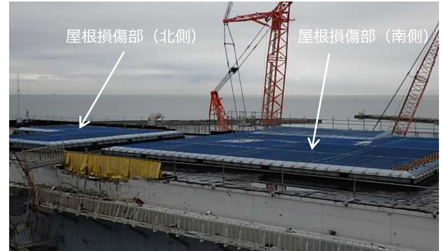
屋根状況【流入防止堰・雨水カバー設置完了】 〔西側から撮影〕
