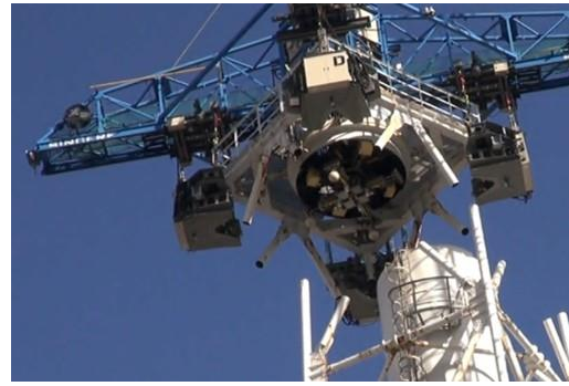
図5 1/2号機排気筒の解体開始（2019年8月）
