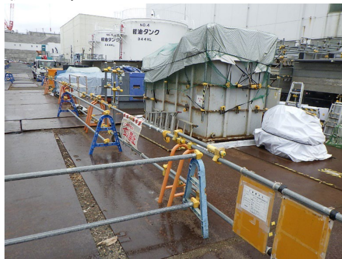
■ 4号機原子炉建屋山側 状況写真 (施工前)
