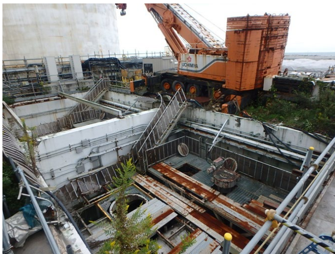
■ 4号機タービン建屋海側 状況写真 (施工前)
