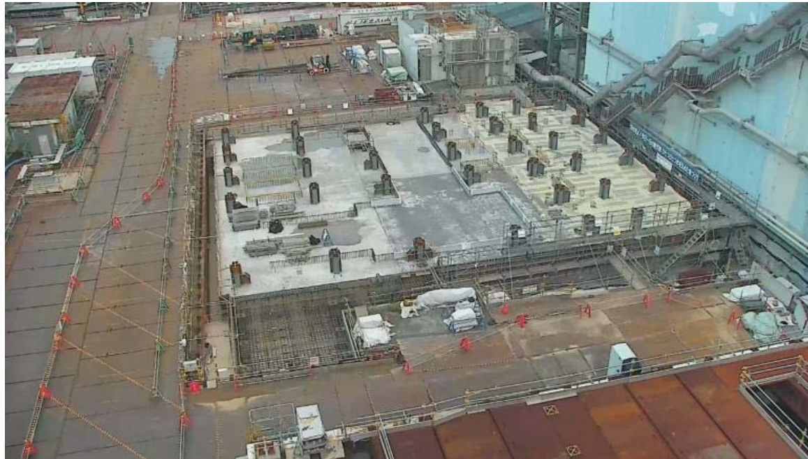
2号機燃料取り出し構台設置に 合わせてフェーシング実施中
