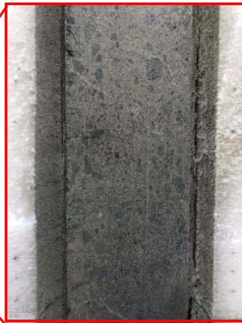
削孔開始から0.5m付近
