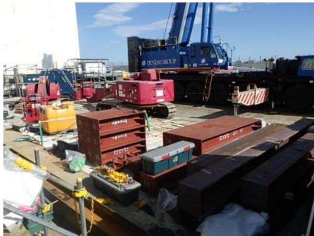
震災時に設置されていたクレーン移動完了 (クレーン移動前の設置個所をフェーシング中)
