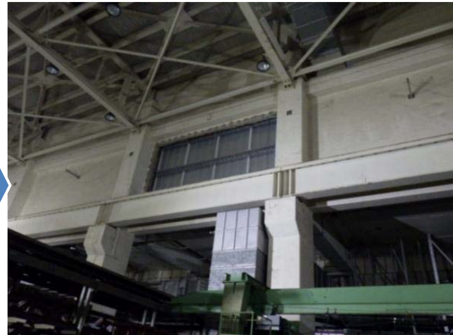
写真②：BOP損壊部分（塞ぎ後、屋内側）
