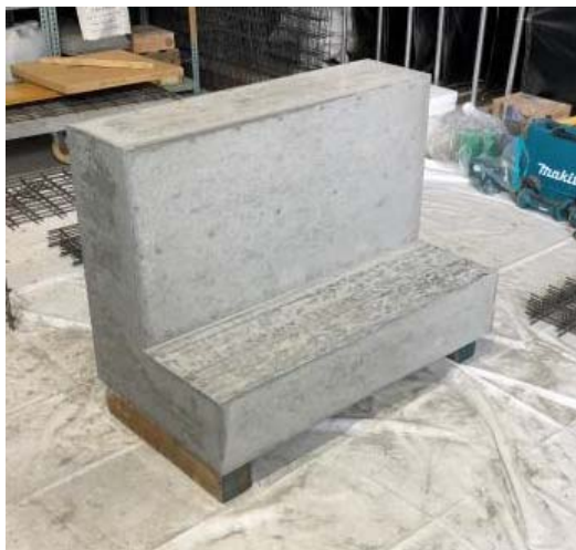
手順1：基礎L型部
