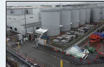
<解体状況(4月21日)>
