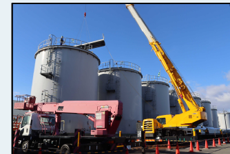
<天蓋撤去状況(2月14日)>
