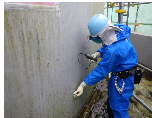
側板肉厚測定状況
