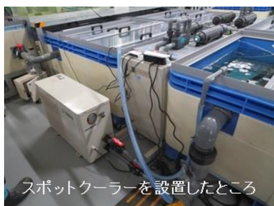
本設のクーラー 4tの海水を冷やします
