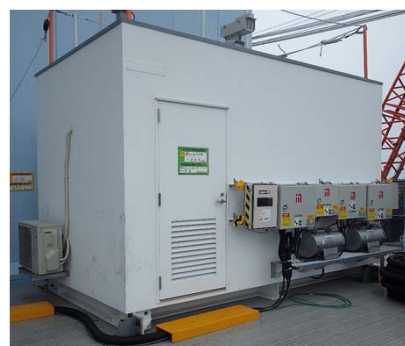
⑥遮へいコンテナ (構台上)
