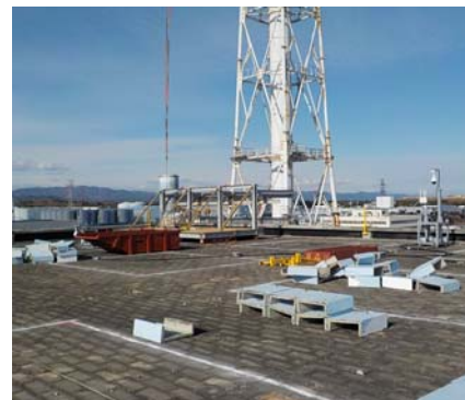
②屋上の現況
