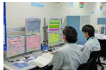
②免震重要棟での集中監視
