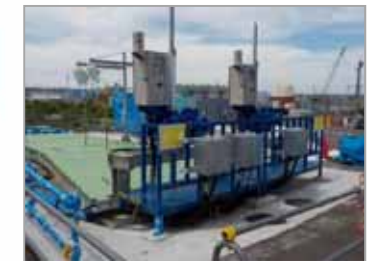
③B・C排水路 ゲート弁設置・電動化
