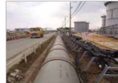
①排水路暗渠
