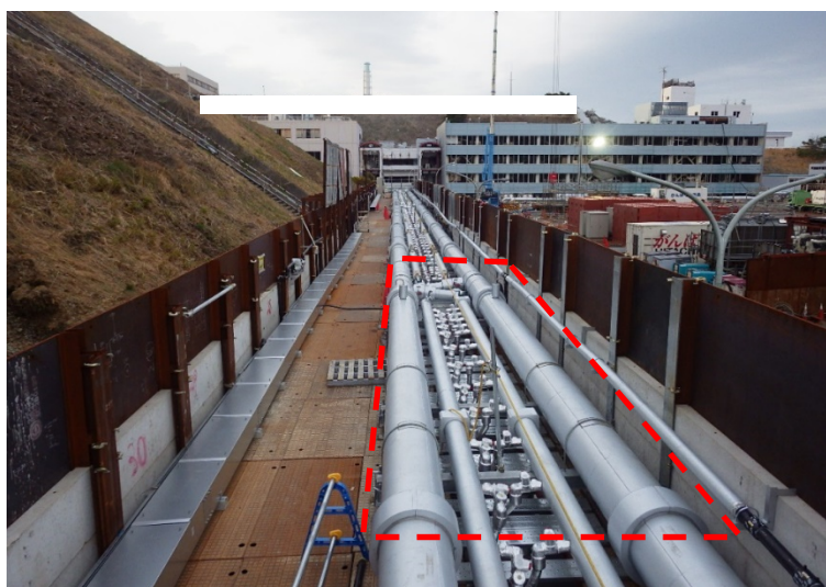
図－3 配管類撤去箇所の例
