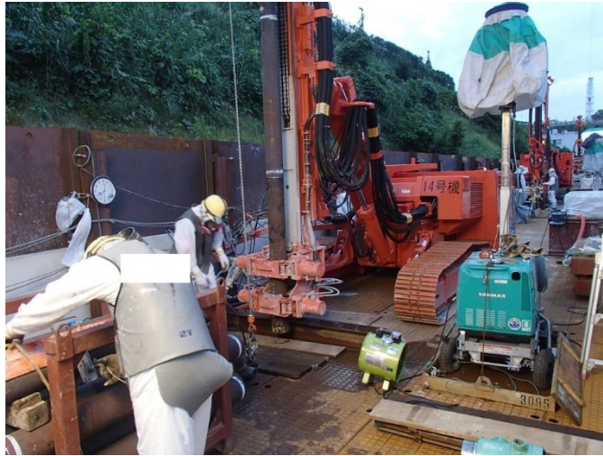
図-4 ボーリング削孔（イメージ）
