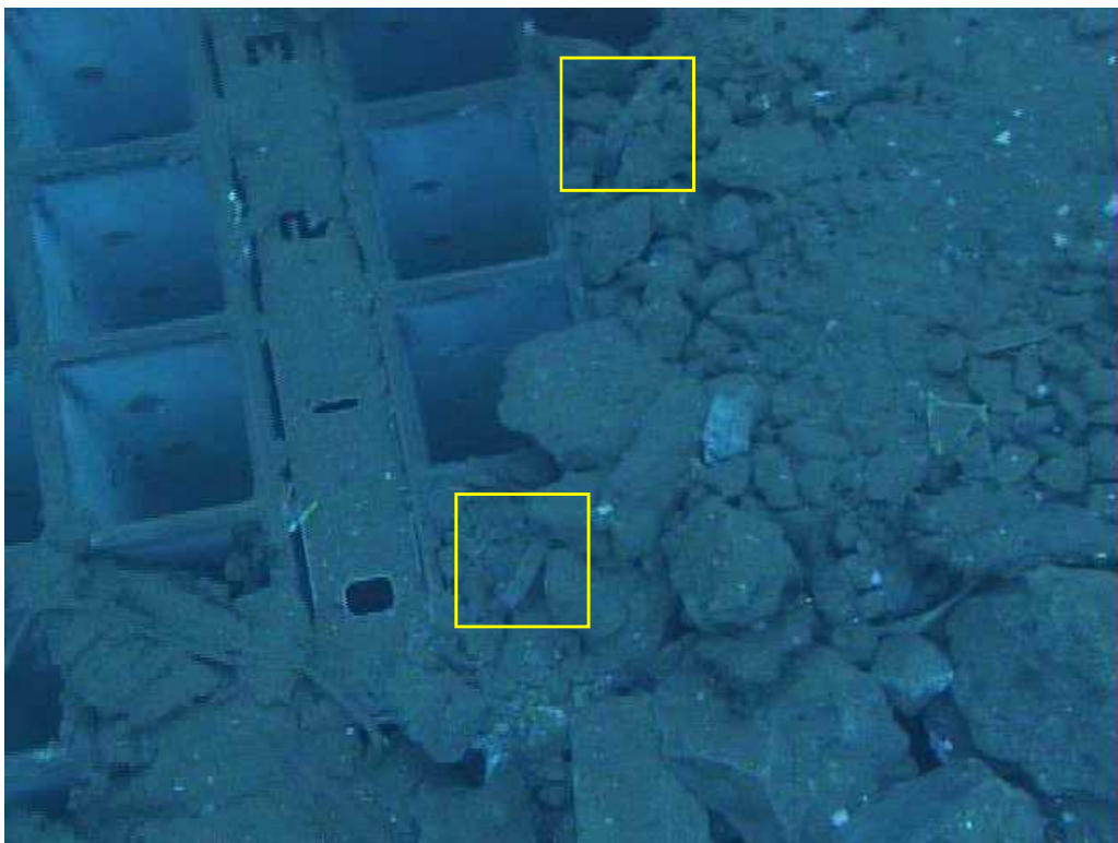
CUW ハッチ落下箇所
