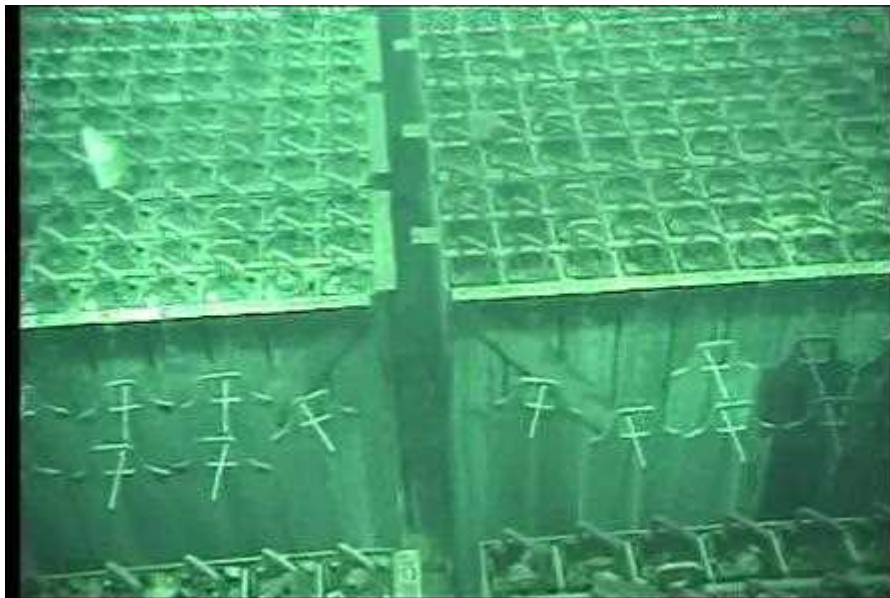
図6-2 4号機SFP内の状況（その2）
