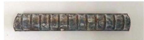
No.2（腐食グレードI）
