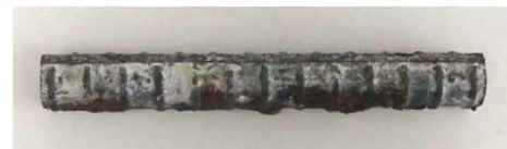
No.1（腐食グレードII）
