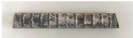
No.3（腐食グレードI）
