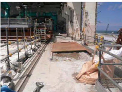
④床異常なし
