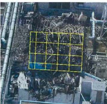
図-4.1 3号機原子炉建屋の損傷状況（立面図）
