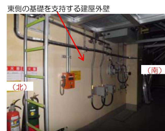
東側の基礎を支持する建屋外壁
