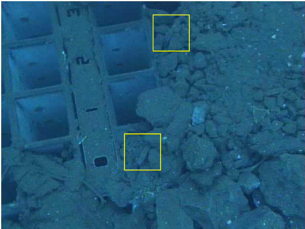
CUW ハッチ落下箇所
