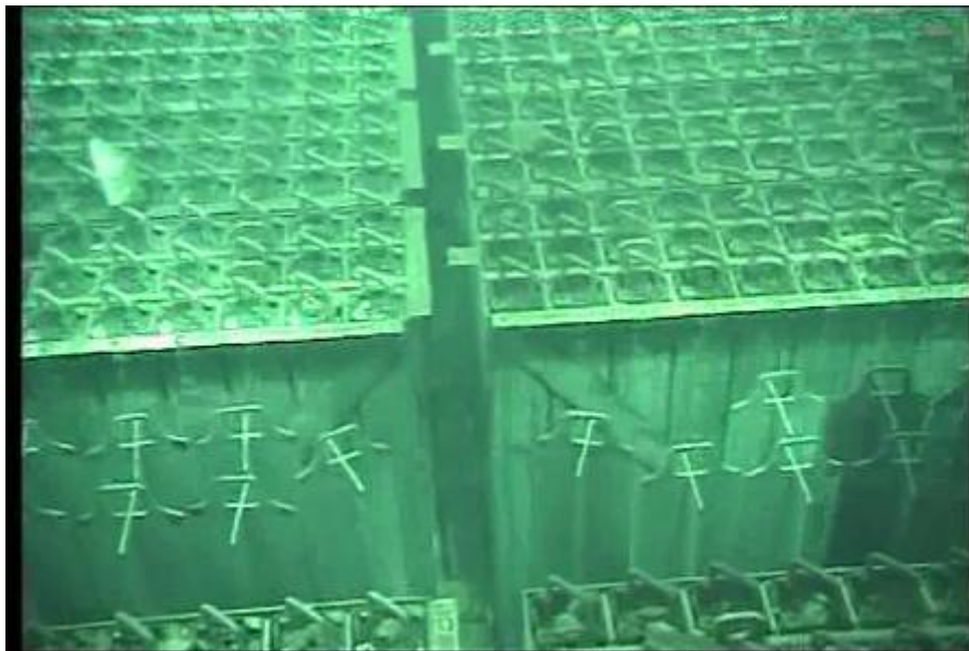
図6-2 4号機SFP内の状況（その2）
