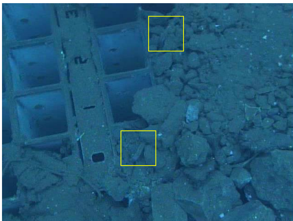
CUW ハッチ落下箇所
