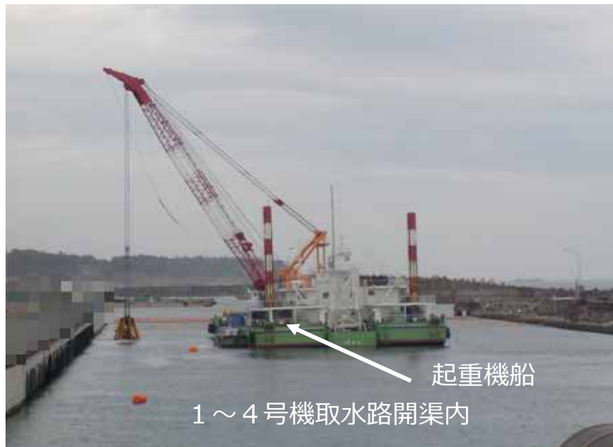
写真① <海側遮水壁防衝盛土工事の様子>
