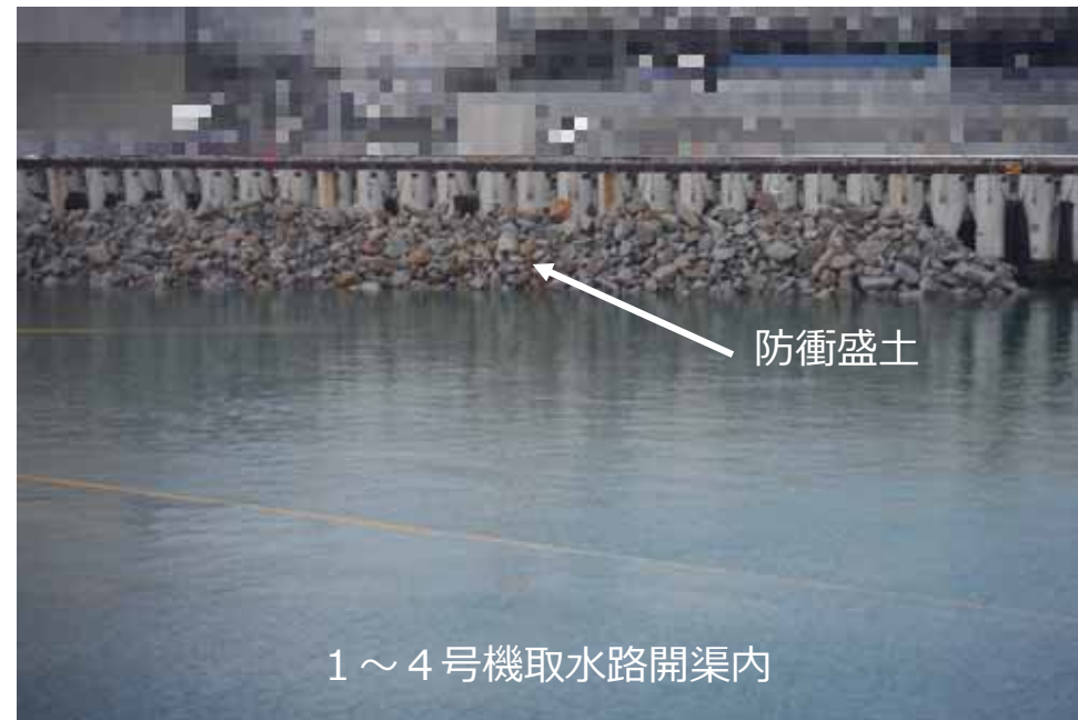
写真② <海側遮水壁防衝盛土>
