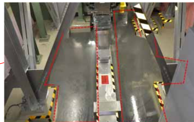
<漏えいした水の状況>
