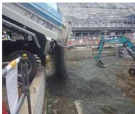
① 碎石敷き込み
