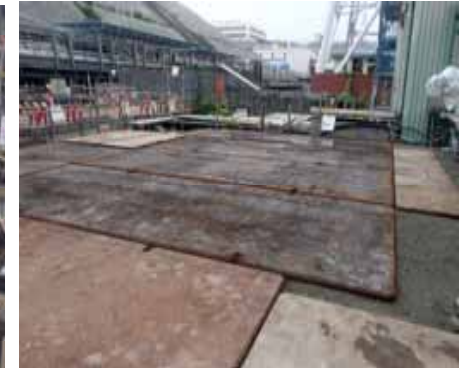
④ 敷鉄板設置
