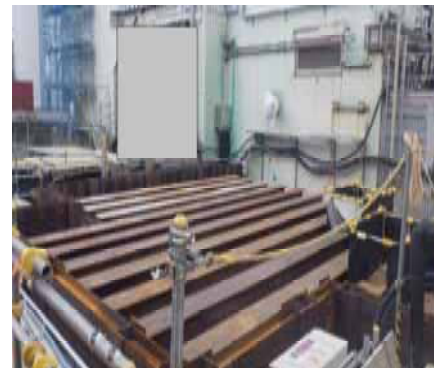
③ 補強鋼材設置
