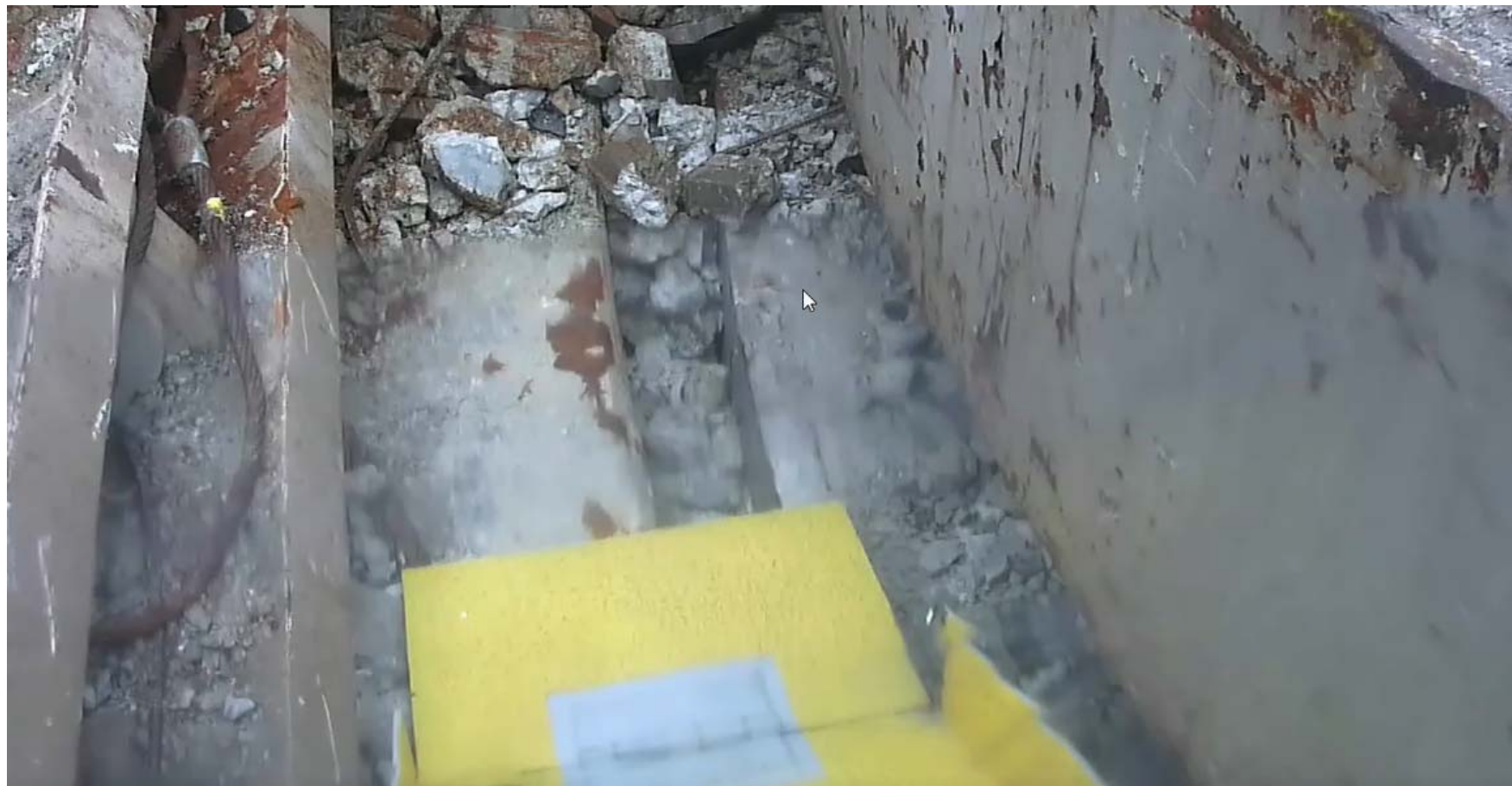
運搬ボックス内のカメラから撮影したDSPカナルプラグ上の状況
