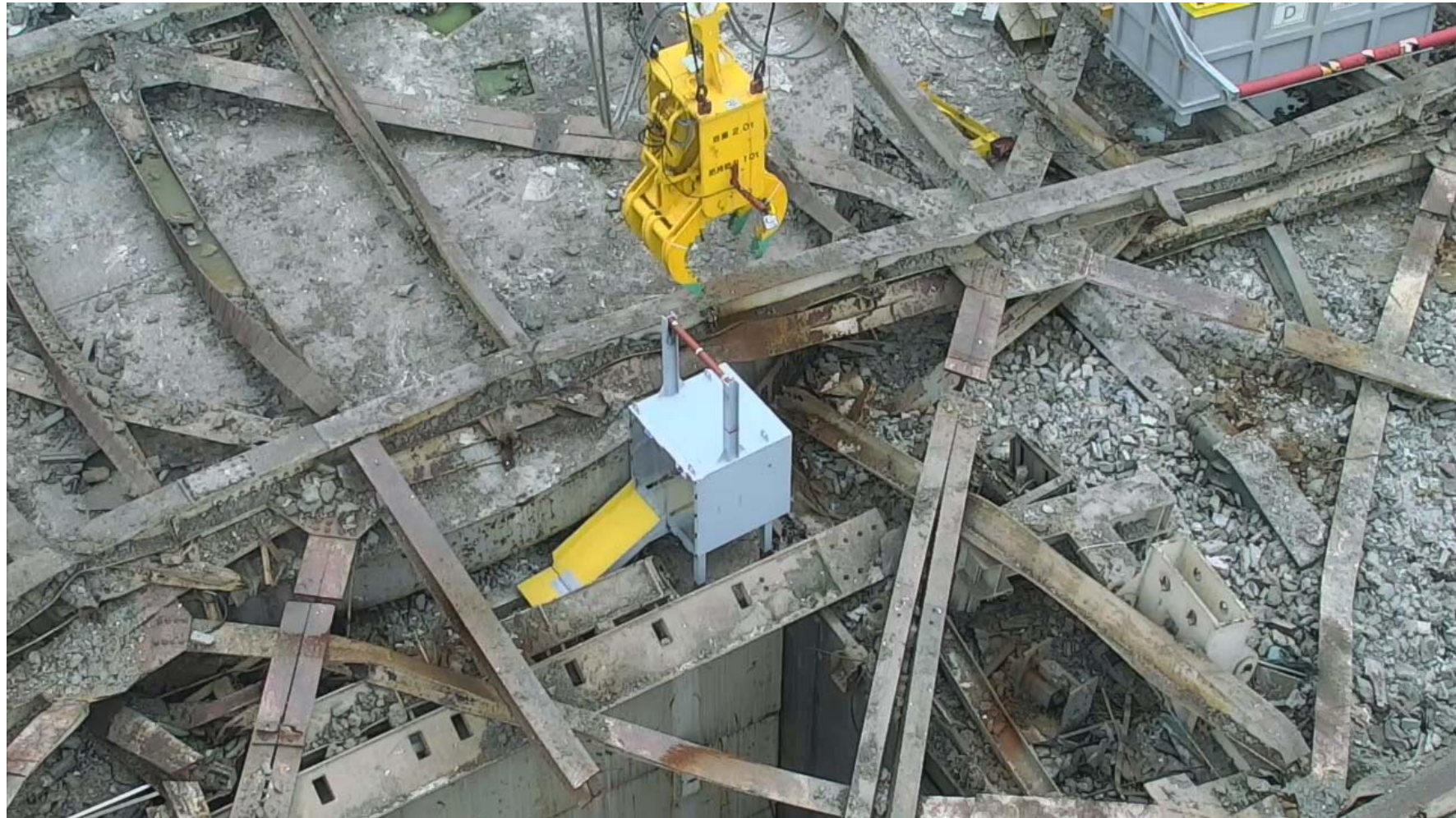
運搬ボックスがオペレーティングフロアに着座した状況
