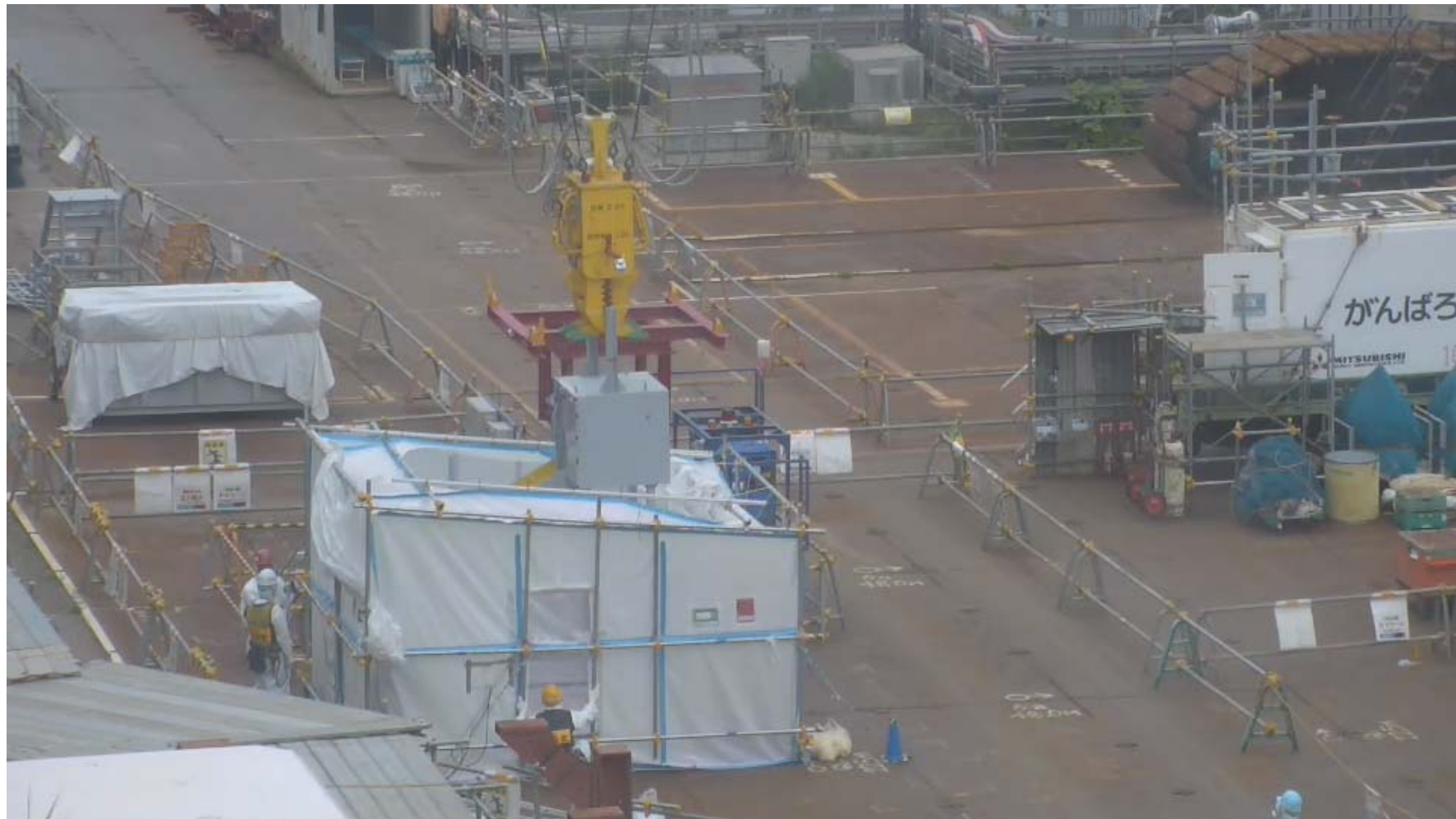
運搬ボックスがヤードから引き上げられている状況
