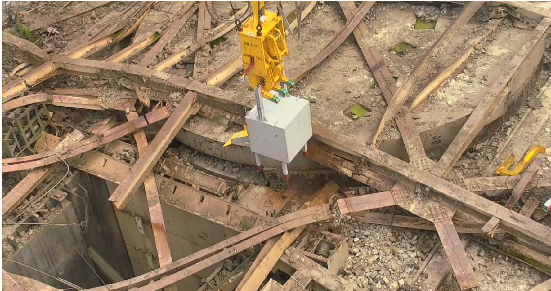
運搬ボックスがオペレーティングフロアに着座する直前の状況
