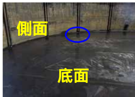
【参考】同型タンク内面写真（水抜き後）
