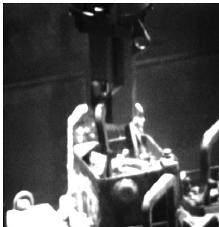
吊り上げ試験の状況 (次頁⑮)
