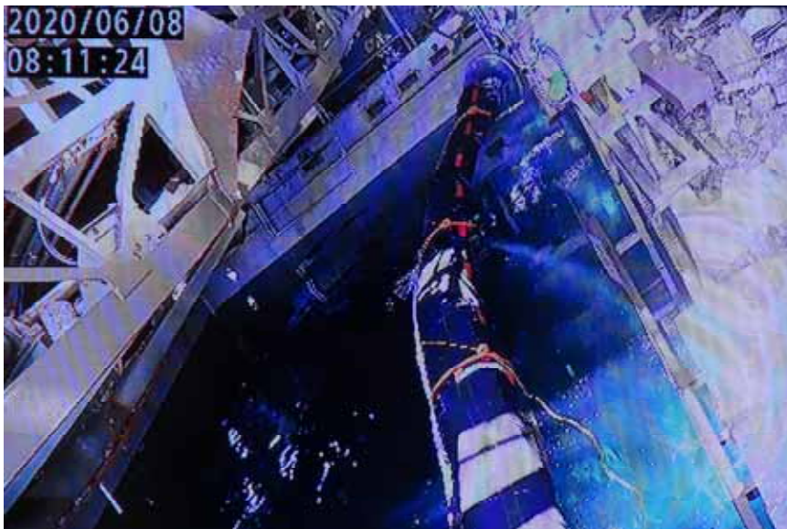
図5.SFPへ養生バック投入後※
