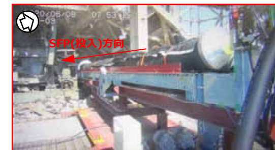
図2.オペフロ作業床に設置された養生バック及び養生バック投入装置※
