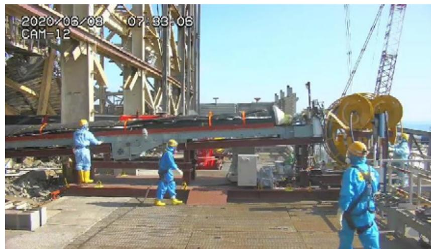
図3.養生バッグ投入前の投入装置確認作業(6月8日撮影)
