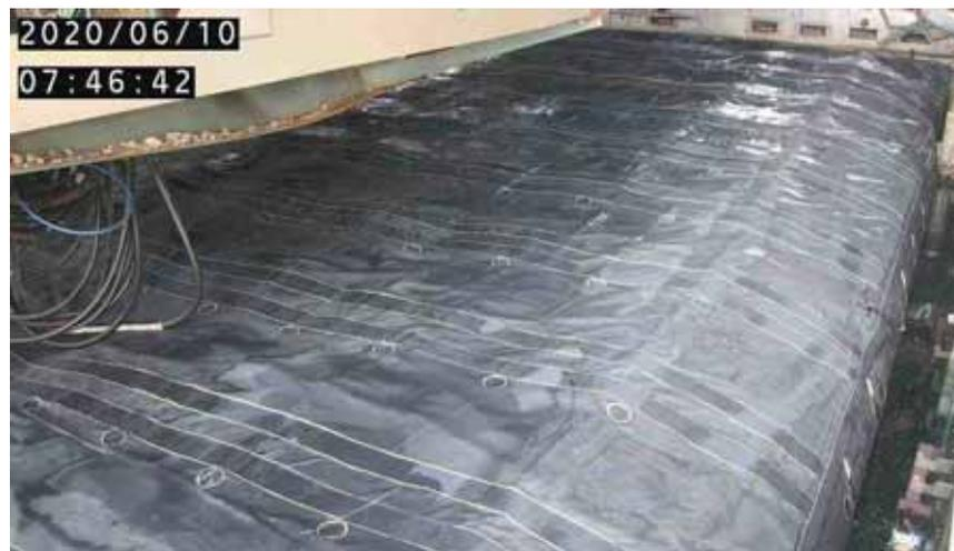
図5.養生バッグエア注入後のSFPの状況(6月10日撮影)
