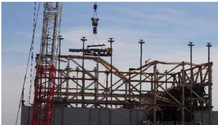
図2.養生バッグ投入装置の吊上げ作業(6月7日撮影)
