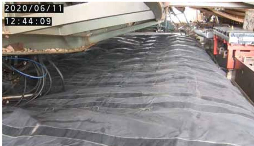
図1.エアモルタル充填が完了した養生バッグ(6月11日撮影)
