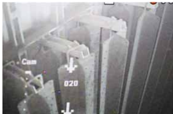
【SFP内の制御棒・制御棒ハンガーの様子】
