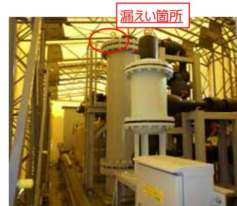
浄化ユニット内の吸着塔(漏えい箇所)
