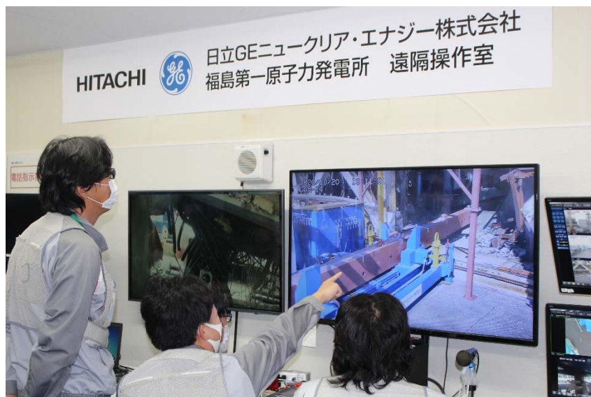
図3.遠隔操作室における作業状況
