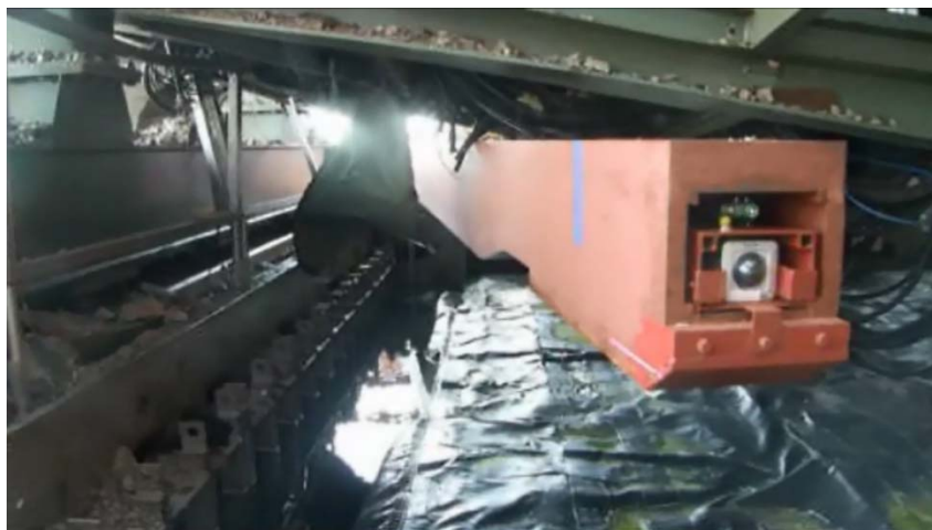
図5.支保梁挿入作業の状況(10月20日撮影)
