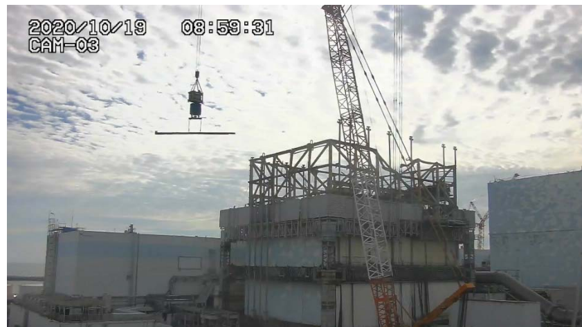
図4.支保梁吊り上げ作業の状況(10月19日撮影)
