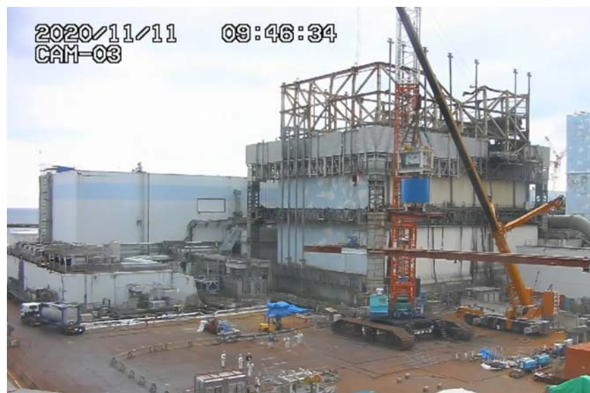
図4.支保台車走行用レール吊り上げ作業の状況(11月11日撮影)
