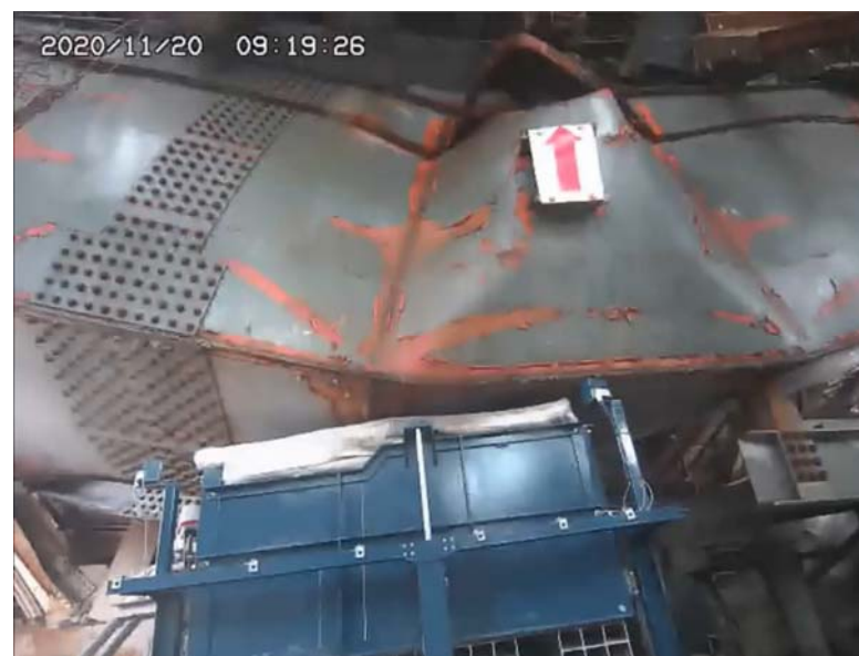
図6.支保バッグ内部へのモルタル充填作業後の状況(11月20日撮影)
