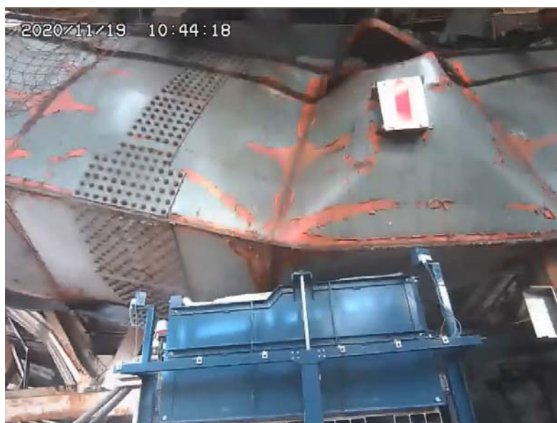
図5.支保台車設置作業後(モルタル充填作業前)の状況(11月19日撮影)
