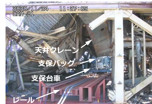
図2.天井クレーン支保設置作業完了後の状況 (11月24日撮影)
