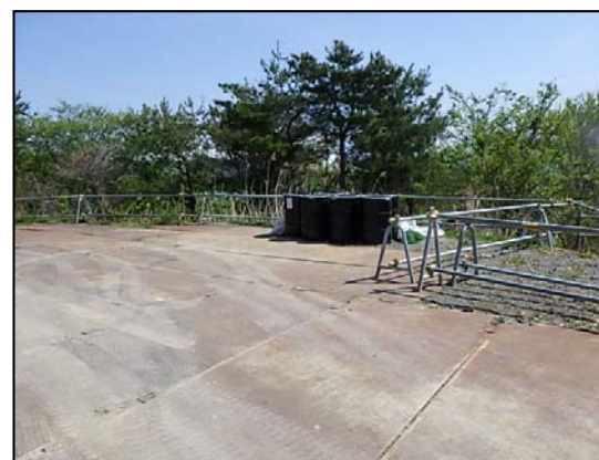
【軽油搬出後の資材ヤードの状況】
