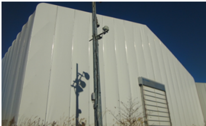
【一時保管エリア A1 テント俯瞰】
