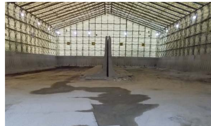
【一時保管エリア A1 テント内部】
