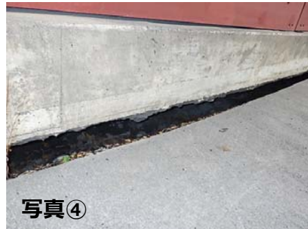
道路の沈下／地盤の沈下等
