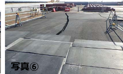
舗装の沈下・割れ／護岸全体の沈下／護岸ブロック変位等
