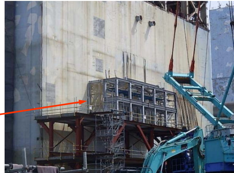
写真2.アンカー削孔装置の設置状況（俯瞰）
